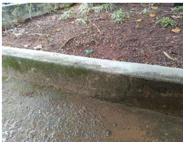
Figura 59: Mureta da entrada antes
