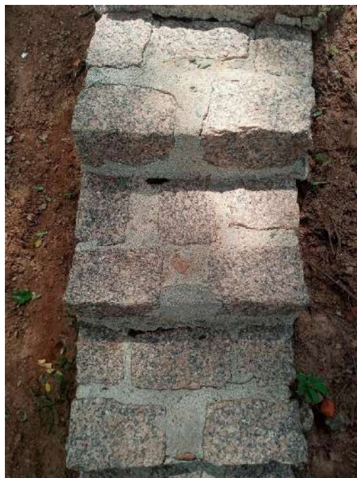
Figura 58: Escada do lago após a lavagem
