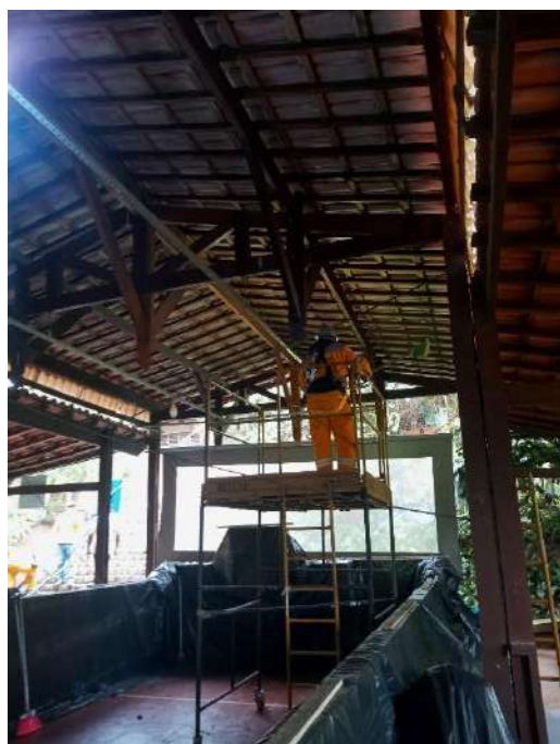
Figura 74: Limpeza de telhado e troca das lâmpadas na bocha
