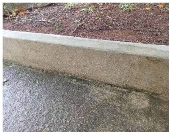
Figura 60: Mureta da entrada após a lavagem
