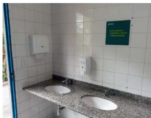
Figura 15: Sanitários com sinalização
