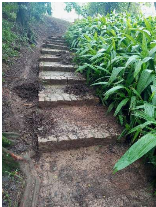
Figura 22: Limpeza das escadas
