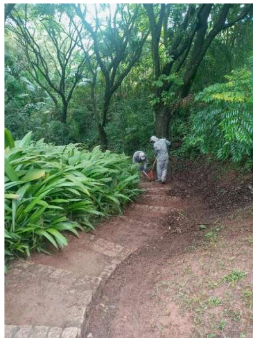
Figura 23: Limpeza de escadas
