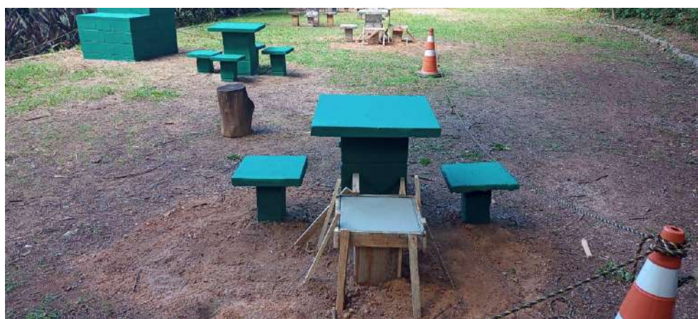
Figura 69: Recuperação dos bancos e fabricação de novos
